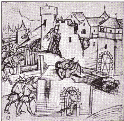
Abb. 7. Belagerung von Murten 1476. Aus W. Schodolers Chronik, Bl. 116b
